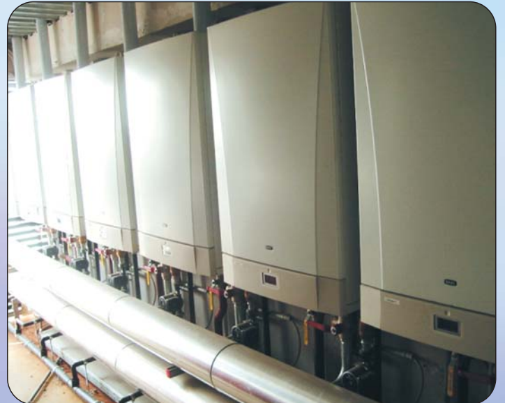
6 Luna HT kazan orjinal hidrolik kit bağlantılı kaskad uygulaması
