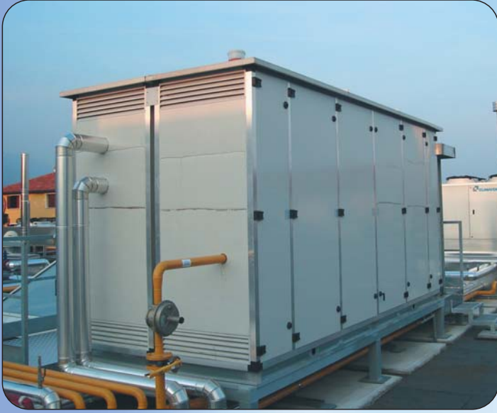
Baca maliyeti düşürülmüş kabin içi çatı kaskad uygulaması
