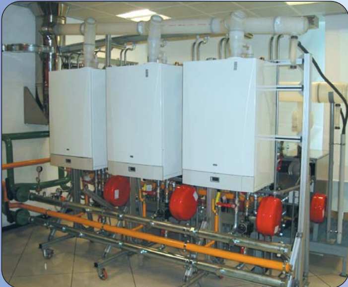
Orjinal baca ve hidrolik kitleri kullanıldığı kaskad uygulaması
